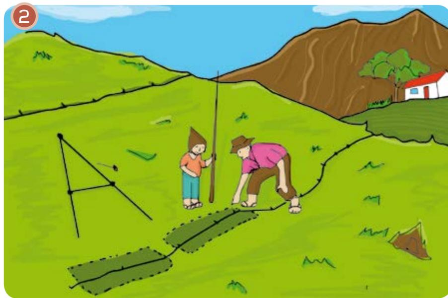
*Para que la tierra de la barrera no caiga dentro de la zanja, se debe colocar a unos 20 cm de separación de las zanjas. Es importante compactar la tierra con los pies o con la pala.*
